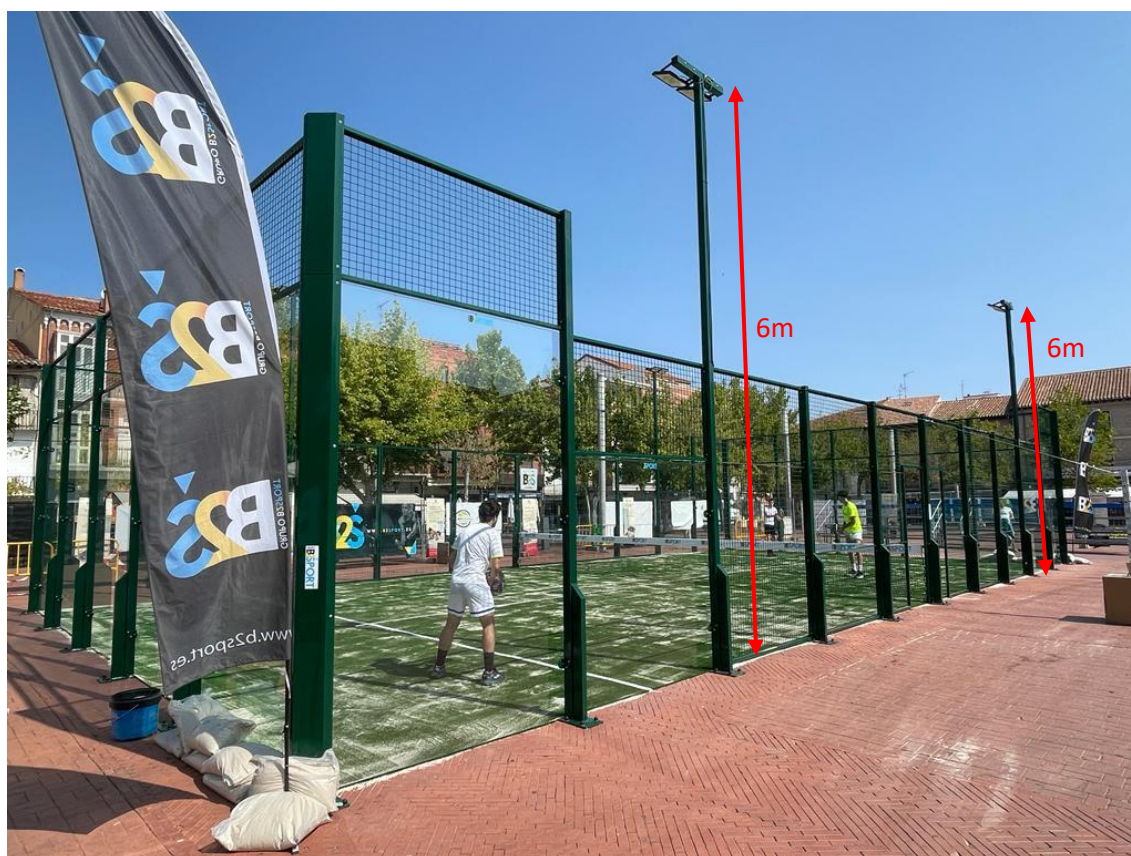
Figura 9: Postes de iluminación.
